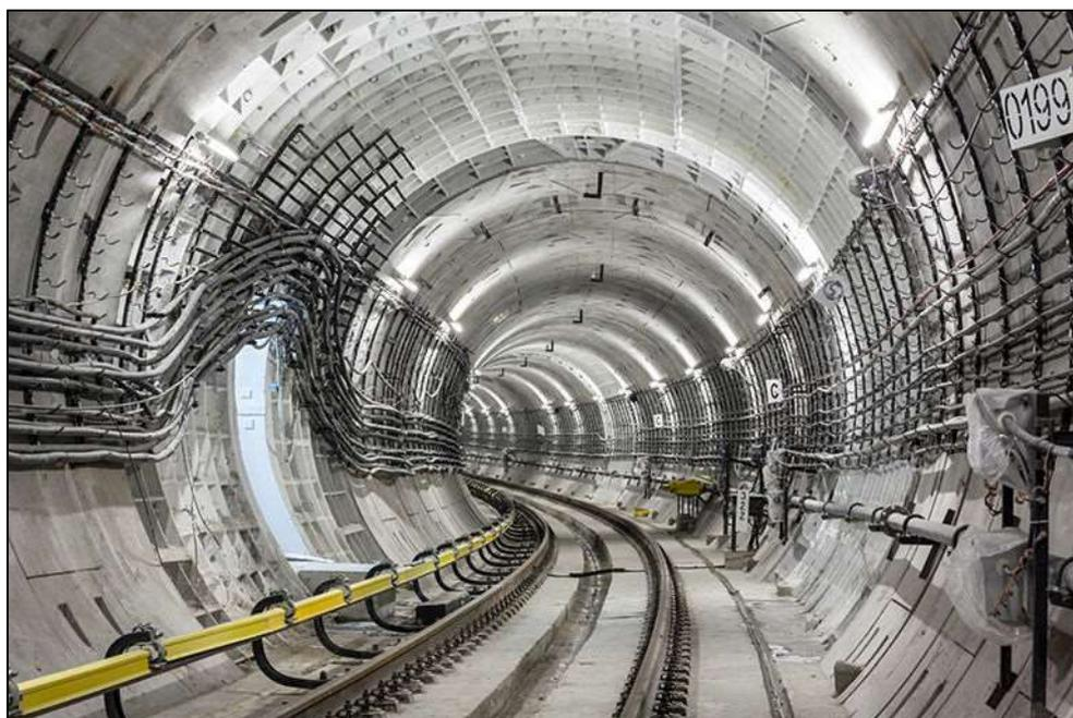
**Ilustración 6. Eleclink, interconexión eléctrica que une Francia con Reino Unido a través del Eurotúnel por donde circulan trenes de pasajeros. Fuente. R. Roca, 2017**
